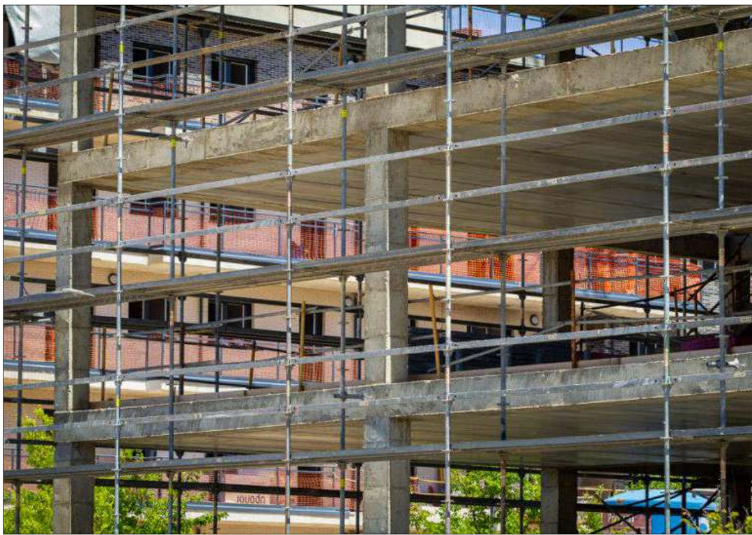
Construcción de vivienda. MARIO TEJEDOR
